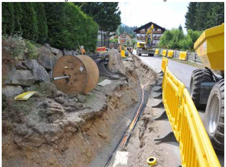
Die Bauarbeiten zur Verlegung des LWL-Kabels sind voll im Gange. Die Aufnahme zeigt die Baustelle im Bereich der Bushaltestelle Plone.
