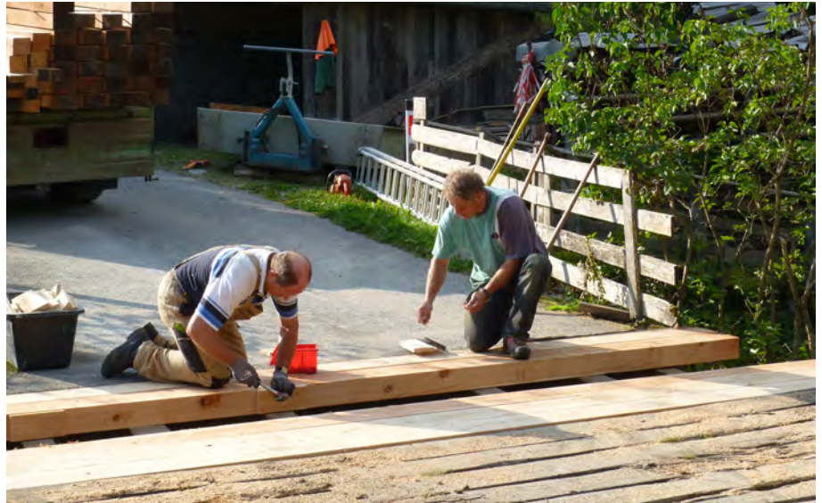
Die Brugger-Brücke wurde von den Gemeindearbeitern Sepp Plattner und Bernhard Tabernig in fast schon routinemäßiger Perfektion mit neuen Die-len ausgestattet. So konnten sowohl Kosten gespart als auch die Bauzeit verringert werden. Für die nächsten 15 Jahre sollte die problemlose Befahr-barkeit wieder gewährleistet sein.
