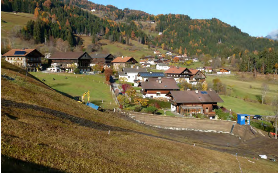
Blick auf das neu errichtete Rückhaltebecken am Schlaitner Dorfbachl
