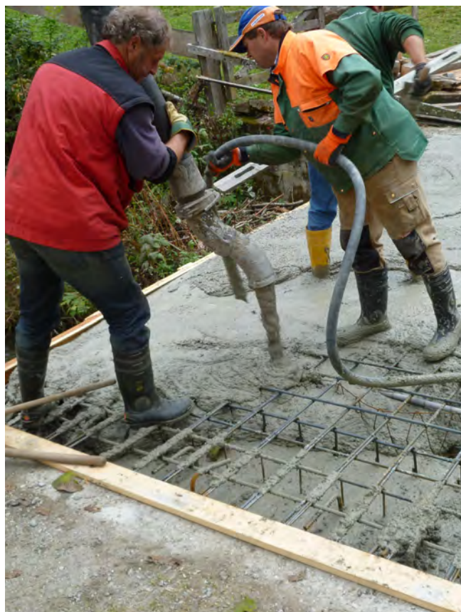
Erstmals errichteten unsere Gemeindearbeiter auch eine Betonbrücke. Nur für die Verlegung der kompli-zierten Eisenkonstruktion war die Unterstützung eines Profis erforderlich.
