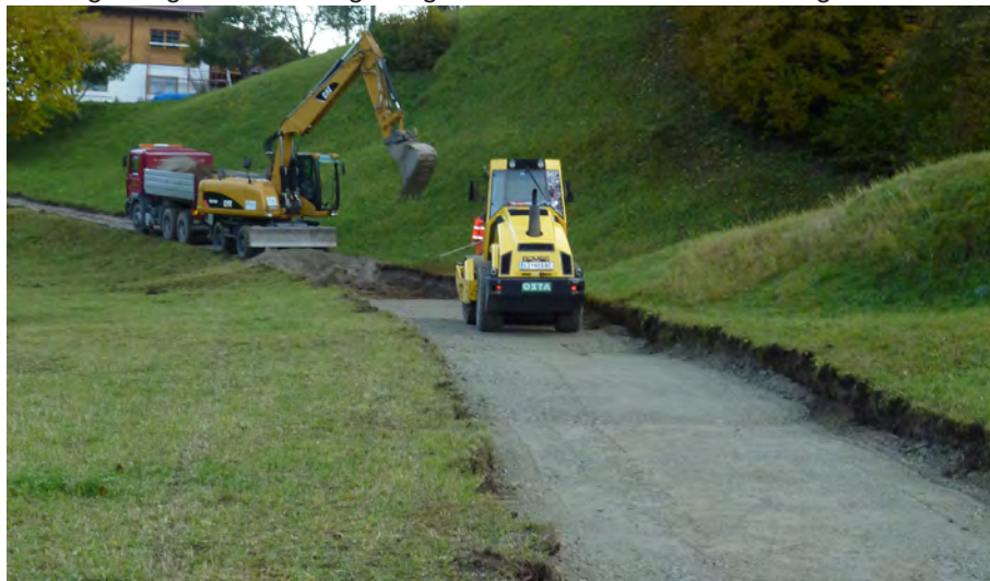
Probegrabungen beim Schlaiten-Gruber-Weg ergaben, dass die Schotterschicht lediglich 10 cm stark war. Die kostengünstigere Variante (Brechen und Einbauen des vorhandenen Materials) war somit nicht durchführbar.
