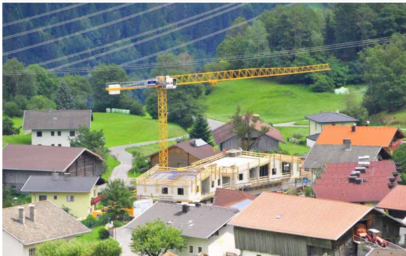
Das Dorfbild wird sich mit der Errichtung der Wohnanlage nachhaltig verändern und doch fügen sich die beiden Baukörper mit ihren Dimensionen sehr bescheiden in die Struktur im Ortskern ein. Noch immer wachen Widum und Gasthaus mit ihrer Höhe über den „Neuankömmling“ im Dorf
