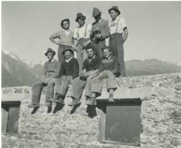
Starke Beanspruchung durch Materiallieferungen für die Futterhausbauten zu Beginn der 50er Jahre. Foto - um 1953 beim Plattner vorne v.l.: Gantschnig Alban, Payr Alois, Heinz Alois (Ainet), Lukasser August (vom Nagele in Ainet) hinten v.l.: Pedarnig Alois, Tabernig Alfons, Plattner Alois und Steiner Johann;
