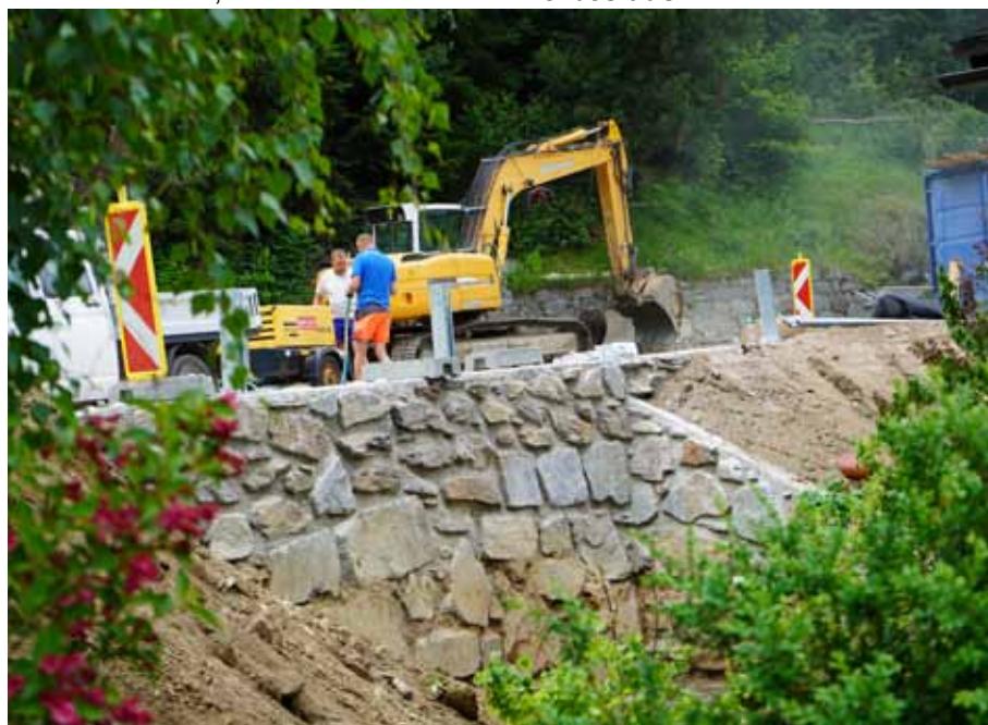
Südöstlich des Wohnhauses Obertschellnig wurde eine Natursteinmauer errichtet. Im Gegenzug konnte die Gemeinde die Weganlage von Michael Waldner ins Öffentliche Gut übernehmen.
