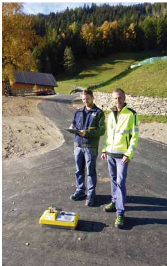
Messung des Hohlraumgehaltes und Verdichtungsgrades des eingebauten Asphaltmischgutes durch die Fa. TPA GmbH/Daniel Roth mit dem Bautechniker der Agrar Lienz Franz Kollreider Foto: Agrar Lienz
