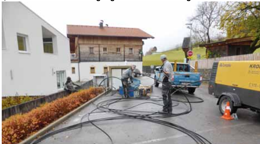
Die Firma STW ist seit einigen Wochen mit dem Einblasen des Glasfaserkabels beschäftigt.
