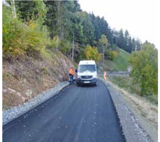
Dichtheitsüberprüfung des Hang- bzw. Oberflächenwasserkanals durch die Fa. Rohrnetzprofis/Obervellach Foto: Agrar Lienz
