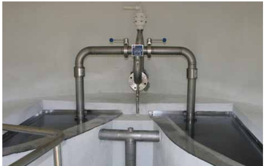
Bei der Generalsanierung des Hochbehälters wurden unter anderem auch die Armaturen im Inneren erneuert. - siehe dazu auch den Bericht auf Seite 9!
