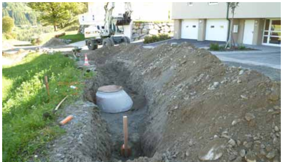
Im Zuge der Asphaltierung der Gemeindestraße in das Gantschfeld wurde auch ein Oberflächenwasserkanal errichtet.
