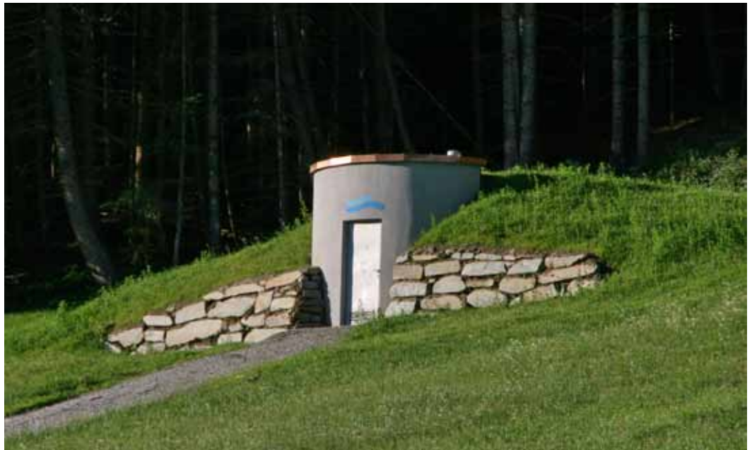
Im Zuge der Generalsanierung des Hochbehälters konnte mit dem Grundeigentümer auch hinsichtlich einer adäquaten Zufahrt das Einvernehmen erzielt werden. Laufende Wartungsarbeiten sind dadurch mit weniger Problemen verbunden.
