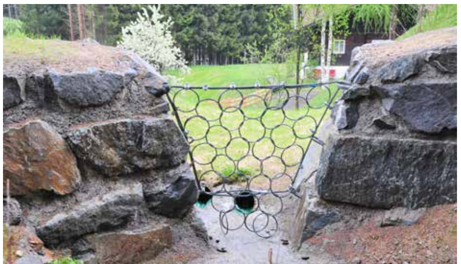
Auch im Bereich der Hofstelle vlg. Hupf waren einige Maßnahmen notwendig: Erneuerung der Brücke, Gerinnesicherung und Geschieberückhaltebecken.
