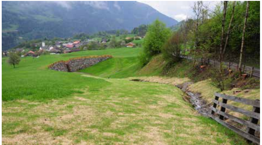
Die Hochwasserretentionsanlage im Votzfeld wurde bereits größtenteils im Vorjahr fertiggestellt. Heuer wurde noch der Bachverlauf bis zur Göriacher Straße verbaut.
