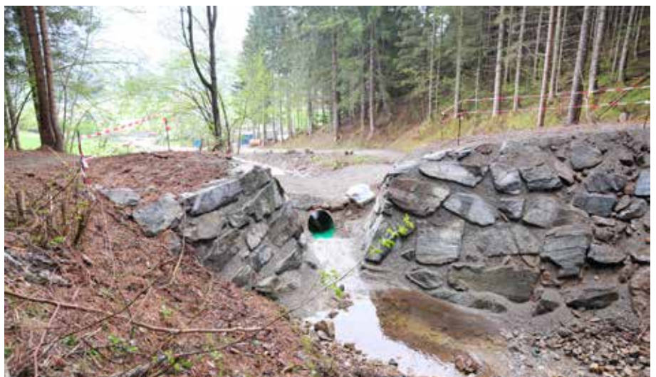
Das Petötschbachl als rechtsufriger Zubringer des Grabenbachls wurde ebenfalls mit Grobsteinschichtung ausgelegt - Regelprofil 1 m 3 . Es wurde ein kleines Geschieberückhaltebecken errichtet.
