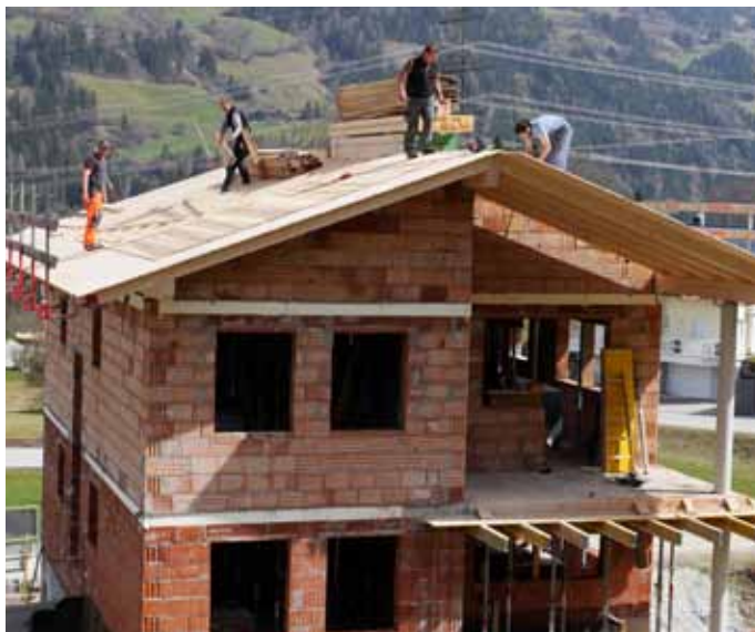
Noch im Rohbau: Das Eigenheim von Johannes und Barbara Scheiterer. Fertigstellung und Bezug sind im Sommer 2015 geplant.
