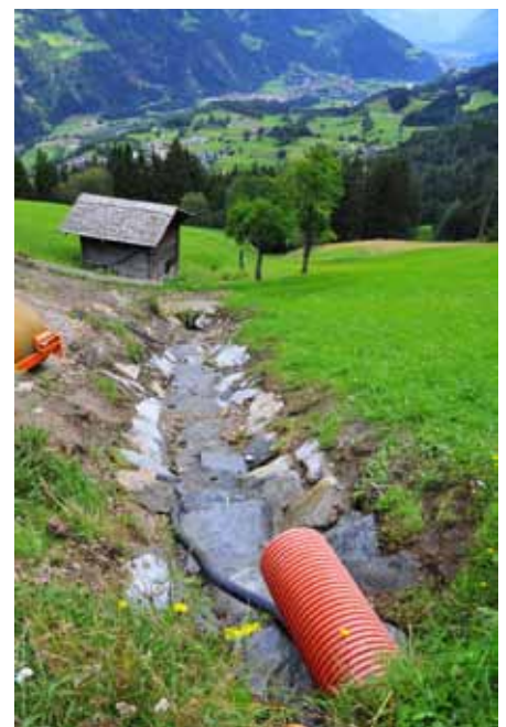
Das Gerinne südlich der Hofstelle Gasser wurde neu ausgekleidet
