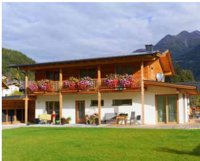
Stefan und Irene Steinkasserer bauten ein schmales Einfamilienhaus in Gantschach.
