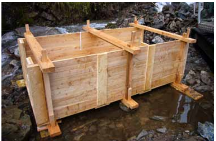
Das Wehr mit den Dimensionen von 2500x1200x750 mm für die Wassermessung am Göriachbach wurde von den Gemeindearbeitern angefertigt und Anfang November 2008 eingebaut. Es wird laufend beobachtet und über die Wassermengen Buch geführt.
