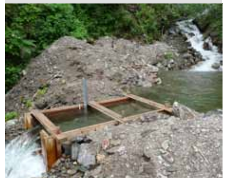
Das Wehr mit den Dimensionen von 2500x1200x750 mm für die Wassermessung am Göriachbach wurde von den Gemeindearbeitern angefertigt und Anfang November 2008 eingebaut. Es wird laufend beobachtet und über die Wassermengen Buch geführt.
