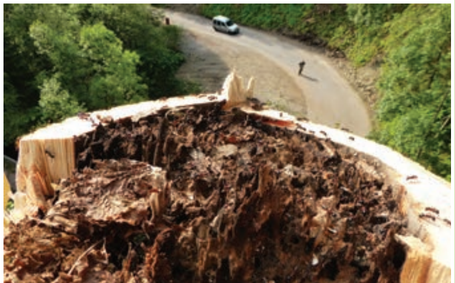
Im Zuge der Fels-Sicherungsarbeiten an der Göriacher Straße musste auch der Bewuchs unmittelbar oberhalb der Daberlebrücke entfernt werden. Diese nicht ganz ungefährlichen Arbeiten wurden vom Maschinenring Osttirol gemeinsam mit den Gemeindearbeitern ausgeführt.
