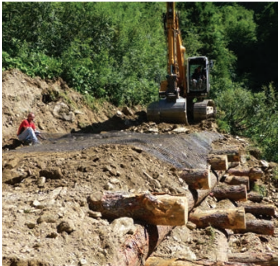
Außerhalb vom Dråßnig-Bachl musste der Almweg auf einer Länge von 30 m mittels einer Krainerwand gesichert werden. Zusätzliche Festigkeit erhält das Bauwerk durch die Verwendung von sog. „Geo-Gittern“
