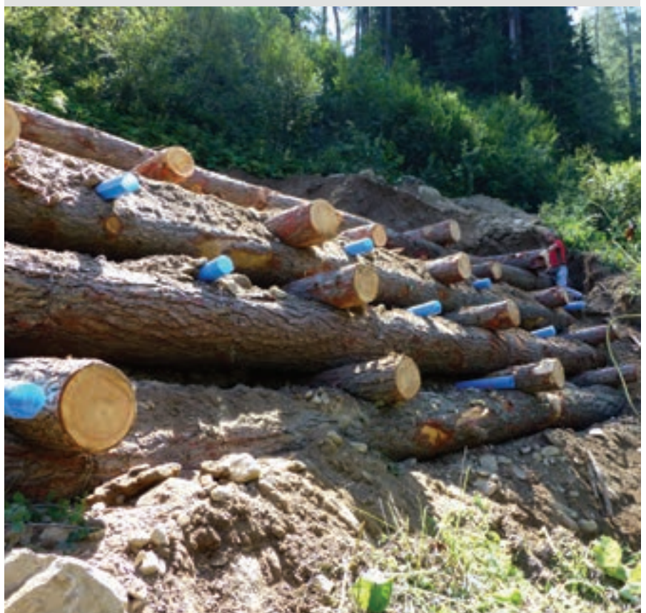
Außerhalb vom Dråßnig-Bachl musste der Almweg auf einer Länge von 30 m mittels einer Krainerwand gesichert werden. Zusätzliche Festigkeit erhält das Bauwerk durch die Verwendung von sog. „Geo-Gittern“
