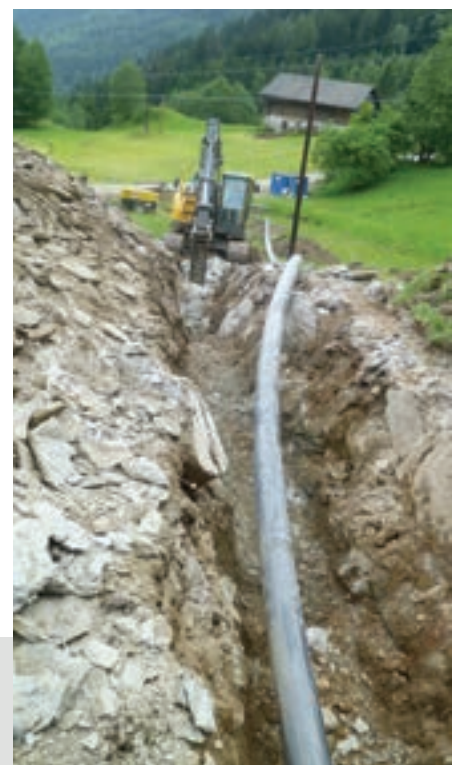
Einer der schwierigen Bauabschnitte war die Abwasserleitung zum Zischgerhof. Neben der talseitigen Sicherung des Weges war auch eine Querung beim Göriachbach durchzuführen.
