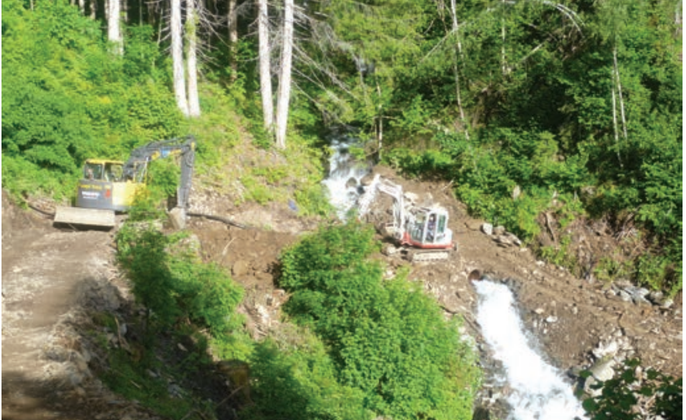
Einer der schwierigen Bauabschnitte war die Abwasserleitung zum Zischgerhof. Neben der talseitigen Sicherung des Weges war auch eine Querung beim Göriachbach durchzuführen.
