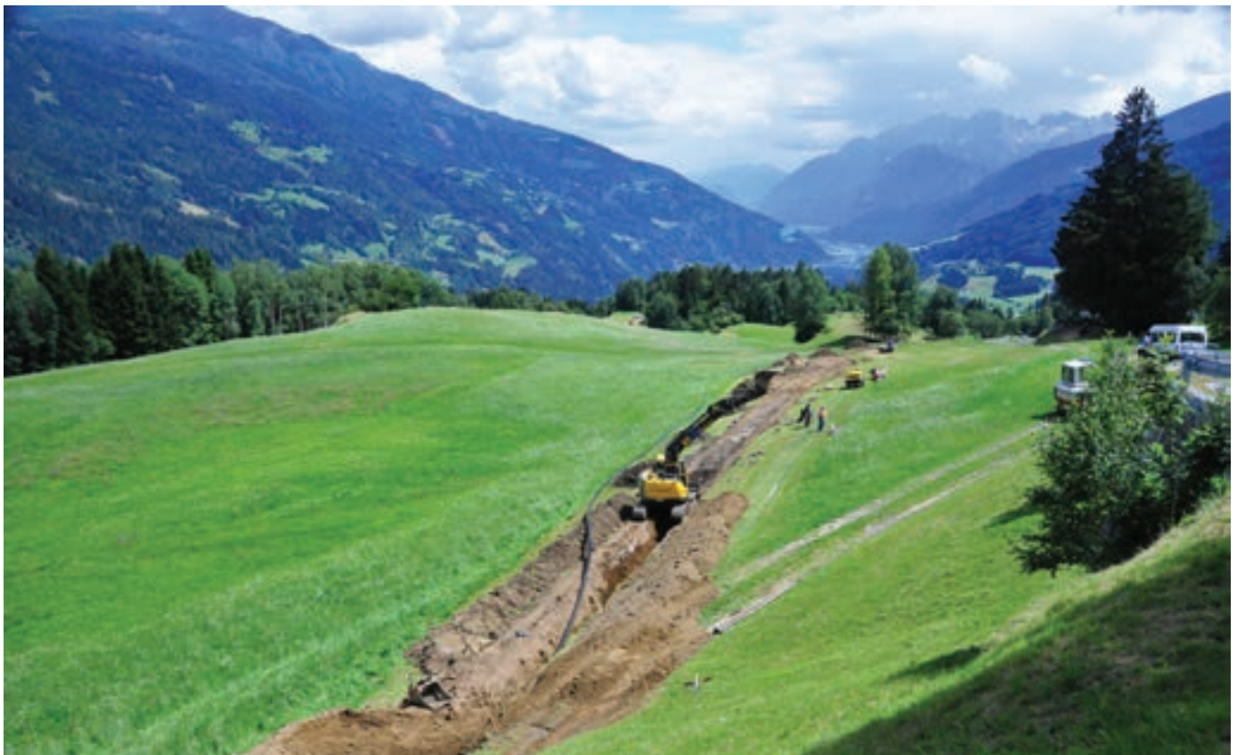
Die wohl größte Baustelle der vergangenen Jahre im Gemeindegebiet, der Kanalbau, konnte heuer abgeschlossen werden.
