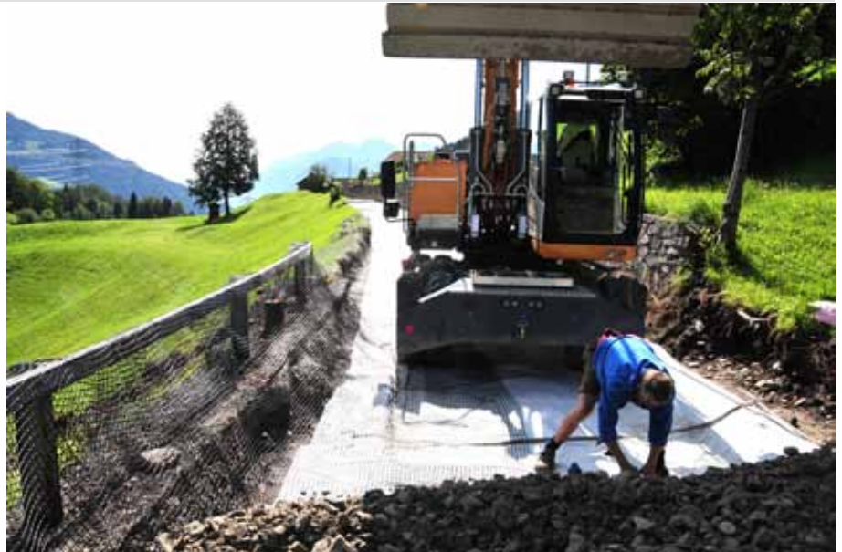
Ursprünglich wären für die Gonzacherstraße in einem Abschnitt von ca. 100 lfm Stützmauern vorgesehen gewesen. Durch den Einbau von Geotextil wird die gesamte Frostkofferpackung derart stabilisiert, sodass der Druck auf die bestehende alte Stützmauer möglichst gering bleibt.
