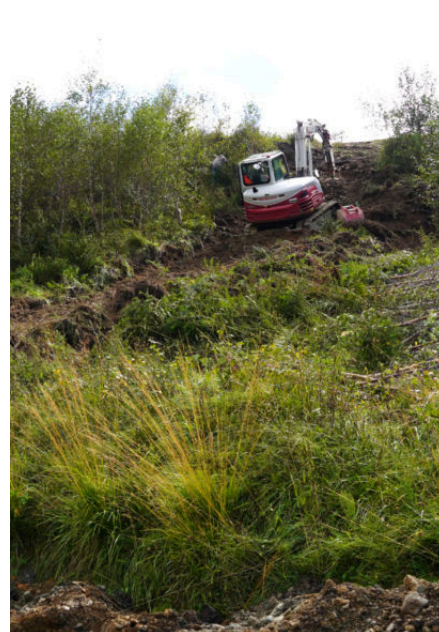
Im Zuge dieses Bauloses wurden 313 lfm Kanalrohre PE-HD 200 mm, 250 lfm Hydrantenleitung PE-HD 90, sowie 223 lfm Hausanschlussleitung PE-HD 50 - teilweise im steilsten Gelände - verbaut.
