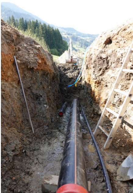
Im Zuge dieses Bauloses wurden 313 lfm Kanalrohre PE-HD 200 mm, 250 lfm Hydrantenleitung PE-HD 90, sowie 223 lfm Hausanschlussleitung PE-HD 50 - teilweise im steilsten Gelände - verbaut.
