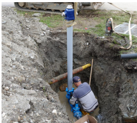
Elektroschweißen der Muffen, Versetzen von Schächten und Hydranten: sämtliche Arbeiten wurden von Martin, Ossi, Bernhard und Markus gewissenhaft ausgeführt.
