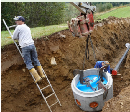
Elektroschweißen der Muffen, Versetzen von Schächten und Hydranten: sämtliche Arbeiten wurden von Martin, Ossi, Bernhard und Markus gewissenhaft ausgeführt.
