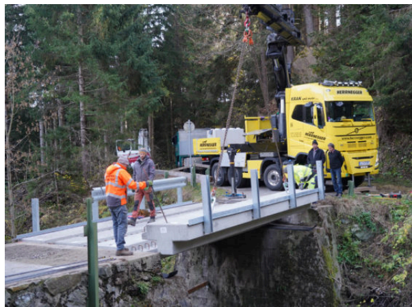
Die Erneuerung der Brücke war logistisch nicht ganz einfach zu bewerkstelligen. Lediglich ein Kranwagen der Firma Hernegger hatte die erforderliche Tragkraft und gleichzeitig auch die entsprechende Fahrzeughöhe für die Stadelbrücke beim Wastler (3,60 m).
