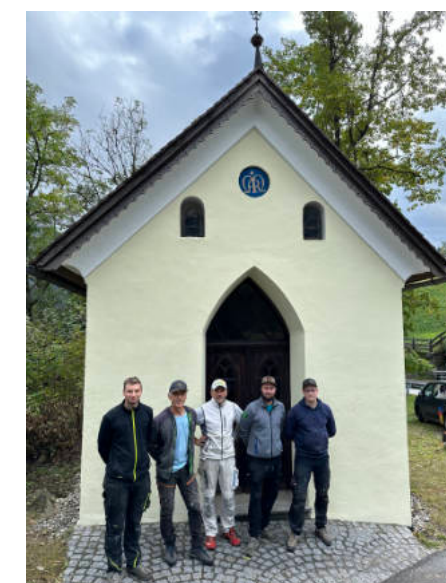
Steiner Andreas, Rainer Johann, Schusteritsch Siegfried, Lumasseger Florian und Brandstätter David sorgten für einen neuen Anstrich an der Außenfassade.
