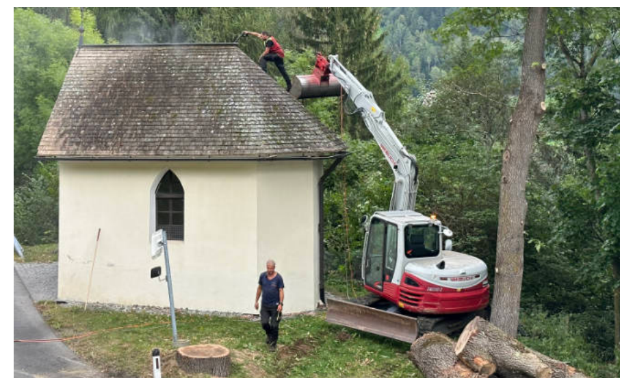
Mit Hochdruck und Baggeruntersützung durch Bernhard Tabernig rückte Markus Holzer der Moosbildung auf dem Dach zu Leibe.
