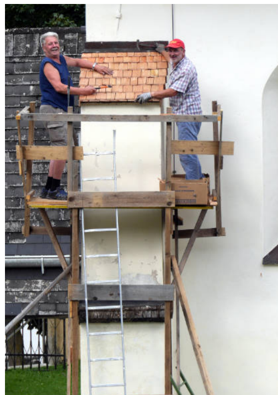
„Dachdeckermeister“ Leopold Gantschnig mit Peter Paul Lumaßegger auf dem Gerüst der Marke „Eigenbau“ in luftiger Höhe bei der Arbeit an den Pfeilerabdeckungen.
