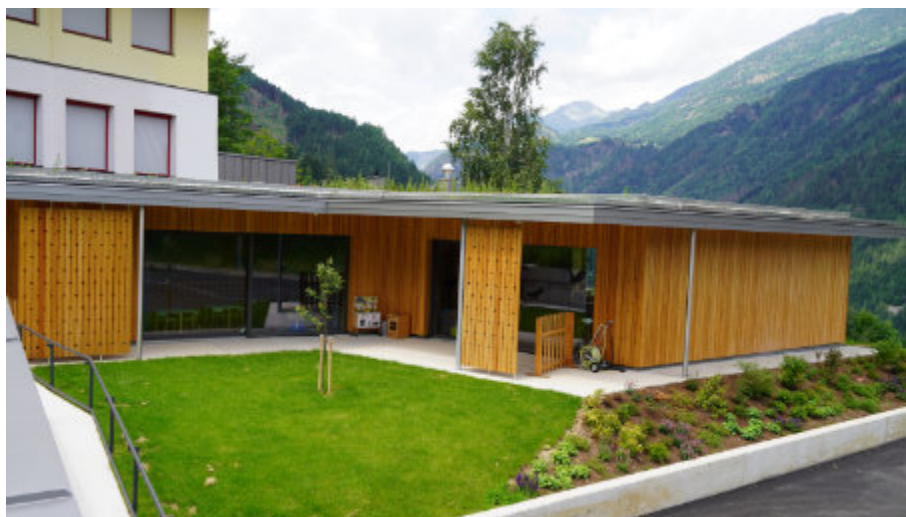
Wo früher der alte Kindergarten mit ca. 100 m 2 Nutzfläche stand, wurde jetzt der neue Kindergarten mit ca. 250 m 2 Fläche errichtet. Zusätzlich ist noch eine kleiner Turnsaal (Bewegungsraum) mit ca. 100 m 2 untergebracht.
