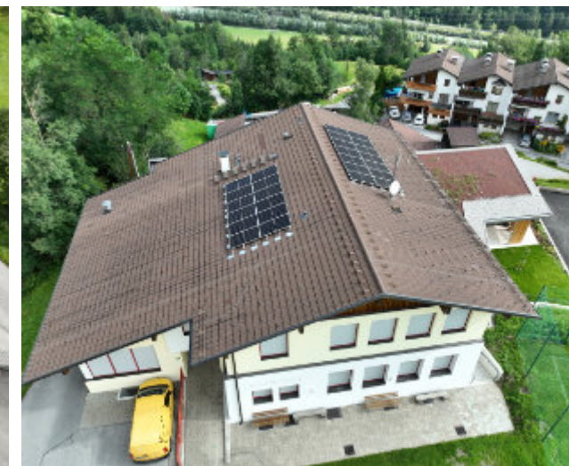
Auf den Dächern des Feuerwehrhauses und der Volksschule liefert die Photovoltaikanlage bereits seit einigen Wochen den Strom, der tagsüber benötigt wird. Die überschüssige Energie wird ins Netz der TINETZ eingespeist. Nach derzeitigen Erkenntnissen ist auch eine Westausrichtung des Daches für die Stromproduktion am Nachmittag geeignet. Daher wurde ein Teil der PV-Module auf diesen Dachhälften montiert. Fotos: Dominic Rindler
