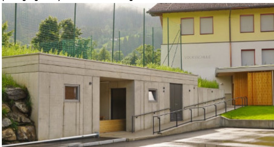
Das Nebengebäude wurde erst im Zuge der Bauphase vom Kindergarten geplant und im Frühjahr errichtet. Untergebracht sind 2 Lagerräume für Jungbauernschaft und Sportunion, sowie ein Raum für ein gemeinsames Notstromaggregat mit 30 kVA für Volksschule, Kindergarten und Bauhof.
