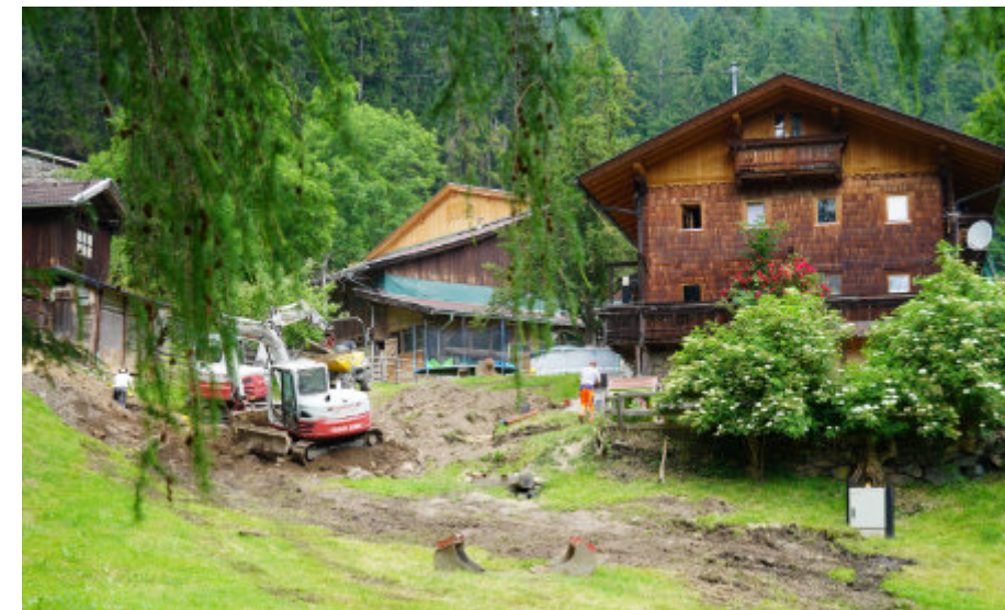
Mit Erschließung der Hofstelle Zischger wurde das vorletzte Gehöft von Schlaiten mit LWL erschlossen. Im Zuge dieses Projektes konnte der langjährige Wunsch, auch die Stromleitung unter die Erde zu bringen, endlich verwirklicht werden.
