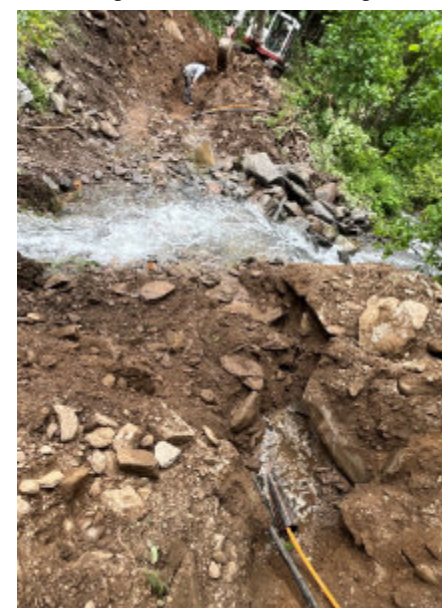
Eine besondere Herausforderung, insbesondere für den Baggerfahrer, stellte die Querung des Göriach-Baches dar.
