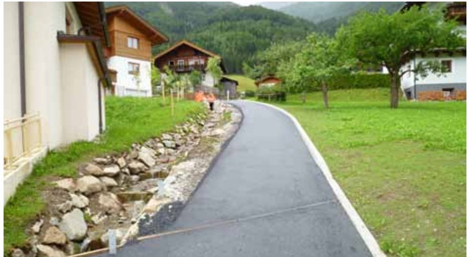
Der prägende Charakter des Dorfbachls konnte erhalten bleiben. Die 220 cm breite Asphaltdecke des „Kirchsteiges“ wird vom Bach durch einen Grünstreifen abgegrenzt. Auf die Randleisten wird noch ein Holzzaun mit Handlauf aufgesetzt. Somit könnte notfalls ein kleineres Räumfahrzeug den Winterdienst übernehmen.
