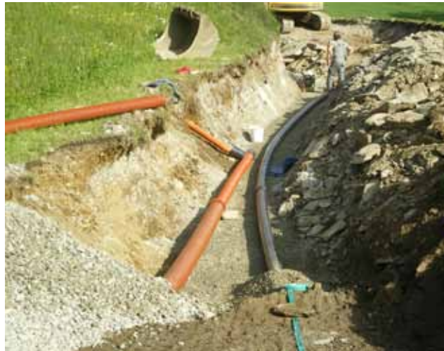
Die Kanalisierungsarbeiten in der Göriacher Straße:
