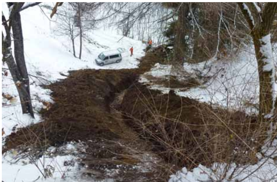
Die Kanaltrasse vom Leitenweg bis zum Untertschellnig weist ein äußerst starkes Gefälle auf. Für die „Profimannschaft“ der Firma Empl war diese Steigung mit dem Schreitbagger aber trotzdem in kurzer Zeit erledigt. Gut zu sehen ist auf dem Foto auch, welche Richtungsänderungen mit dem heutigen Rohrmaterial ohne zusätzlichen Schachteinbau möglich sind.
