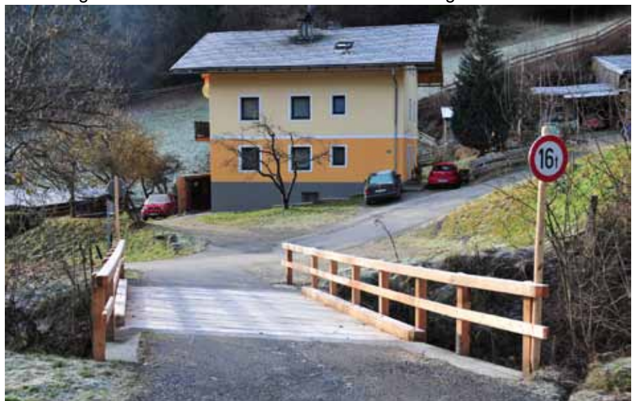
Die „Obere Plonbrücke“ hat sich nach der starken Beanspruchung wegen der Umleitung nach dem Felssturz auf der Landesstraße eine Sanierung redlich verdient.
