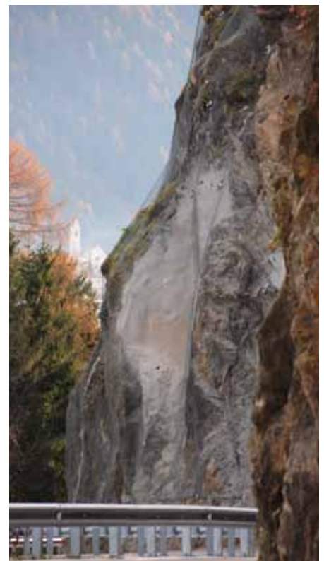
Abbruchstelle nach der Sanierung
