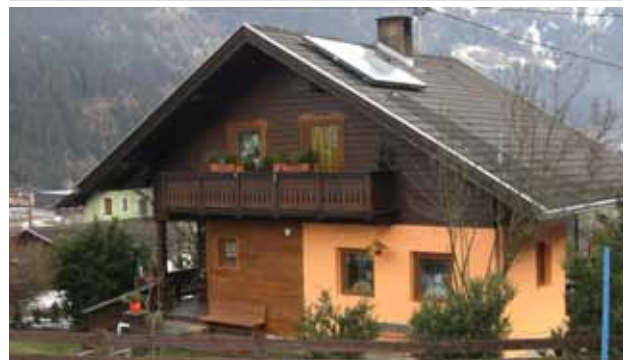
Revitalisierung des alten Wohnhauses in der Plone durch Friederike und Peter Panzl
