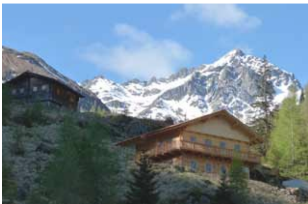
Wiedererrichtung der Huber-Alm (Michelbachtal) nach deren Vernichtung durch einen Brand
