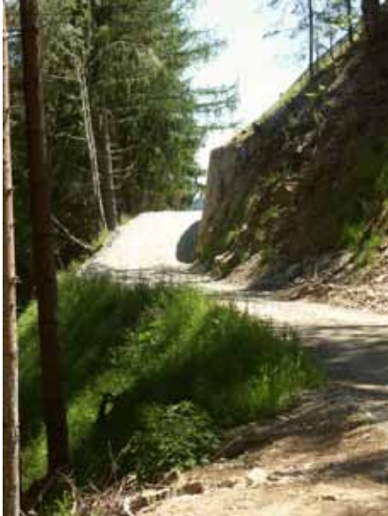
Dank guter Umfahrungsmöglichkeiten, wie hier beim Bodenweg im Jahre 2006 konnten die Bauarbeiten der einzelnen Abschnitte zügig vorankommen.
