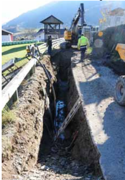
Mit einer Sohlentiefe von 2,79 m beim Anschlusschacht in Gantschach wurden bereits beim 2. Bauabschnitt der Ortskanalisation die notwendigen Vorkehrungen getroffen. Das Widerlager bei der Zischgerbrücke ist exakt um 3 m höher als die Sohlentiefe des Anschlusschachtes. Die Mathematiker unter euch können nun ausrechnen, welches Gefälle bei einer Leitungslänge von 160 lfm erreicht wird.
