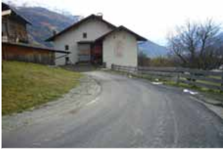
Im Jahre 2009 wurde auch die Hofzufahrt zum Gridling im Zuge der Generalsanierung der Göriacher Straße neu angelegt und mit diesem Programm mitfinanziert.
