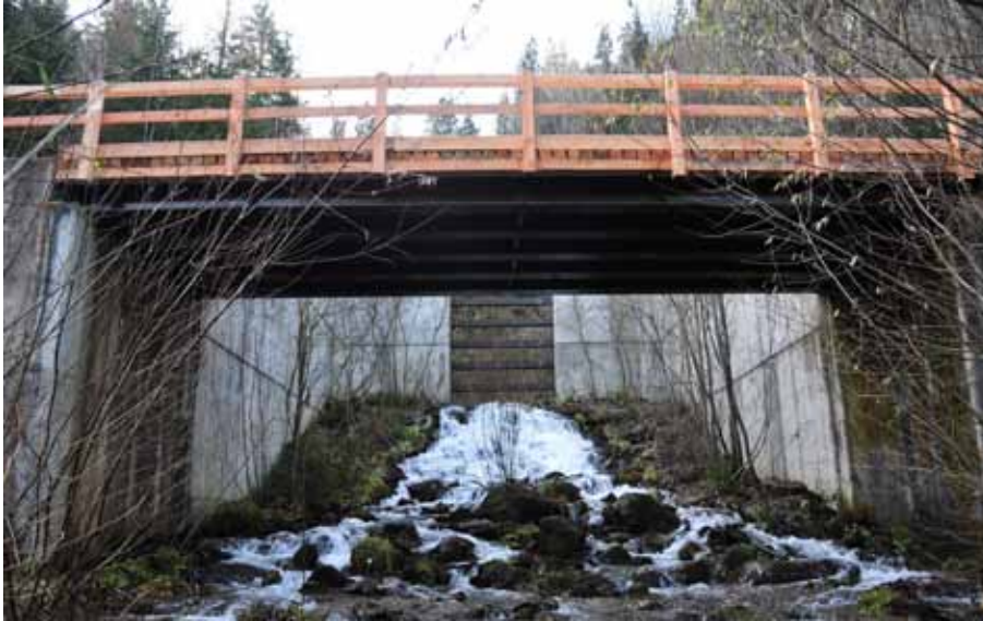
Die „Angerleweg-Brücke“ gehört mit 10,40 m neben der Zischgerbrücke zu denjenigen mit der größten Lichten Weite.
