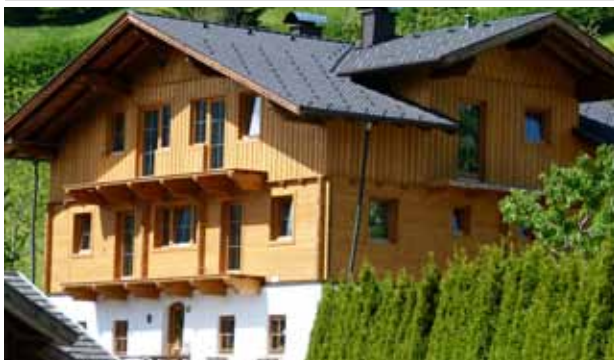
Wohnhausaufstockung beim Wastlerhof in Gantschach
