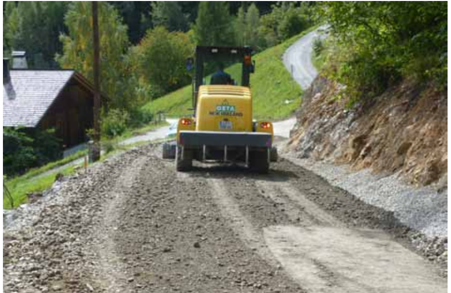
Es gibt inzwischen wahrscheinlich kaum mehr eine Gemeindestraße in Schlaiten, auf der nicht Georg Baur mit seinem Grader von der Fa. OSTA für einen ordentliche Planie vor den Asphaltierungsarbeiten gesorgt hat.
