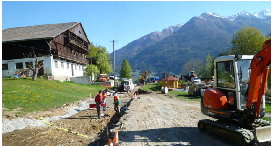
Ein weiterer Baustein in den Straßensanierungsbemühungen der letzten Jahre: die Straße vom „Schoberblick“ (im Hintergrund der Hochschober) bzw. der Hofstelle Außergonig zum Göriacher Parkplatz an der Göriacher Straße.
