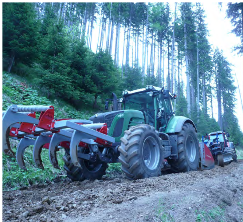
Die Firma Holzer führte die Almwegsanierung im Auftrag der Agrargemeinschaft Michelbach durch. Auf einem Teilstück von etwa 1200 Laufmetern kam eine Fräse zum Einsatz.
