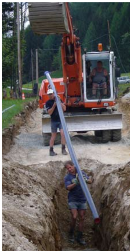
Gemeindearbeiter Bernhard Tabernig u. Partieführer Michael Idl beim Verlegen der 12 m langen Wasserleitungsrohre.
