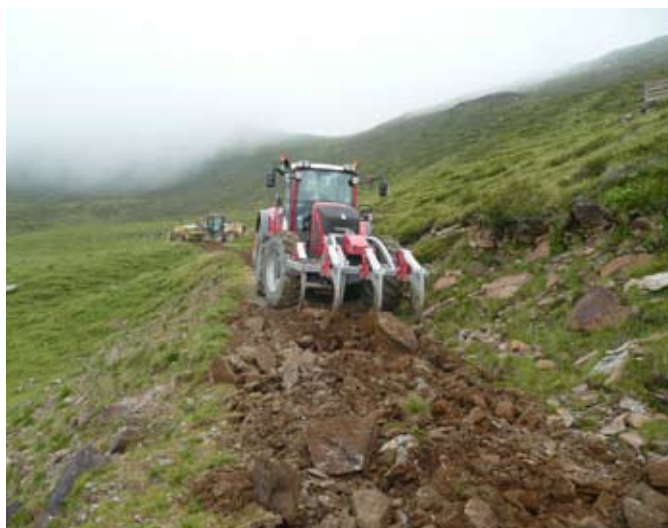
Wegsanierung - Torweg durch die Steirische Firma Profiteam Holzer
