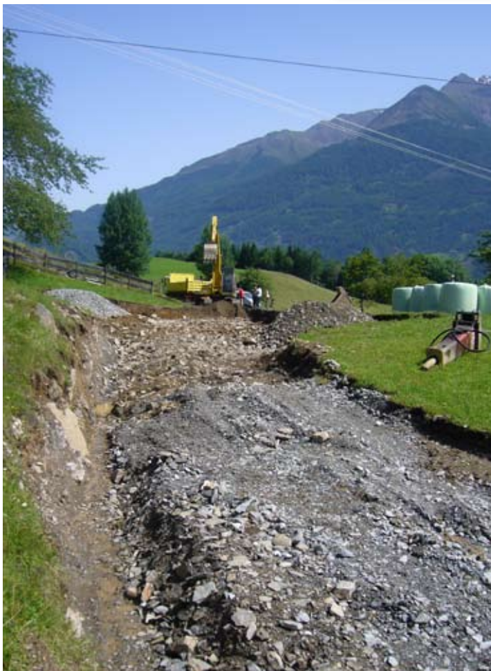
Ziemlich aufwändig gestaltete sich die Sanierung der Hofzufahrt zum Gridling in Göriach. Der Fels musste großteils mit dem Schräghammer abgetragen werden. Zudem waren Wasserableitungen im Bereich der Hofzufahrt zu errichten. Die Asphaltierung wird im kommenden Jahr durchgeführt.
