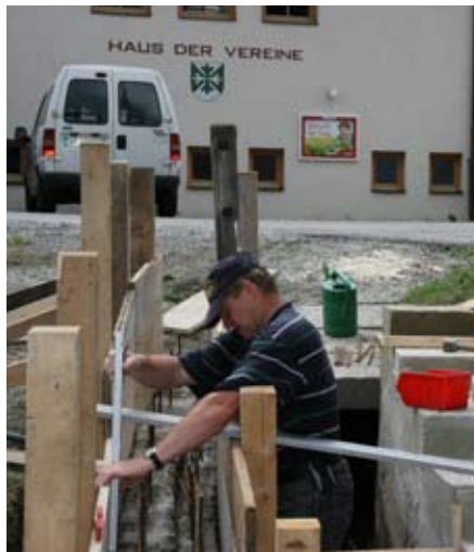
Links: Gemeindearbeiter Josef Plattner bei den Schalungsarbeiten für den Stiegenaufgang zum Dorfplatz.
