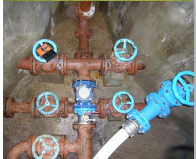
Die Sanierung des Hochbehälters (Schieberkammer und zwei Wasserkammern mit je 75 m3 Nutzinhalt) ist für das kommende Jahr vorgesehen.
