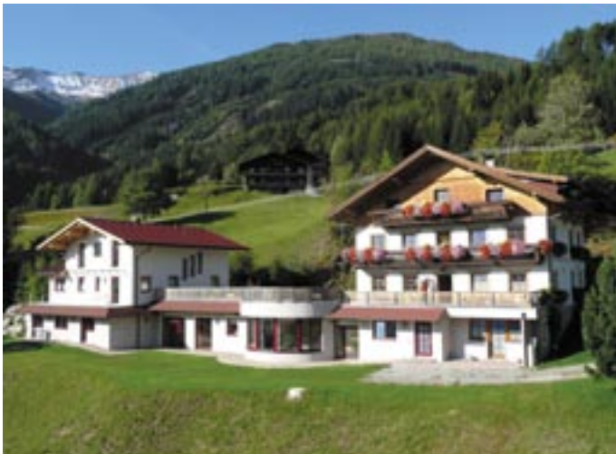
Ein Verbindungstrakt zwischen der Gästepension und dem neuen Wohnhaus beherbergt neben einem Weinkeller mit auserlesenen Weinen auch einen Wellnessbereich mit finnischer Sauna und römischem Dampfbad.
