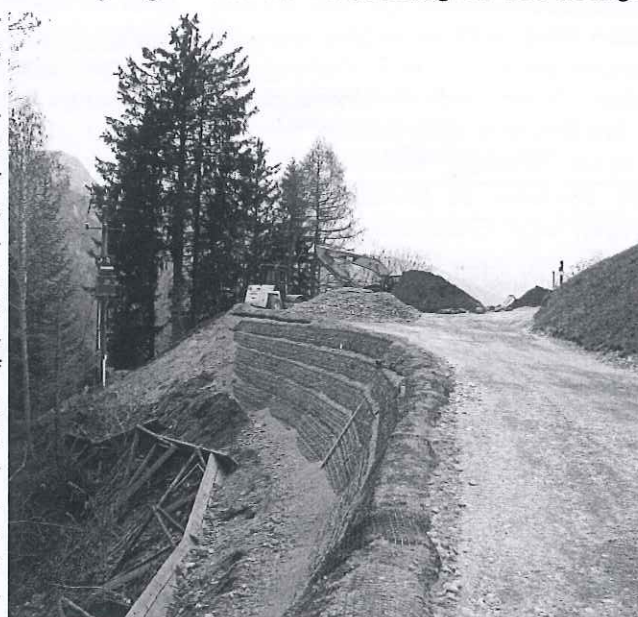
Errichtung von standsicheren talseitigen Böschungen mittels bewehrter Erde (Geo-Gitter).
