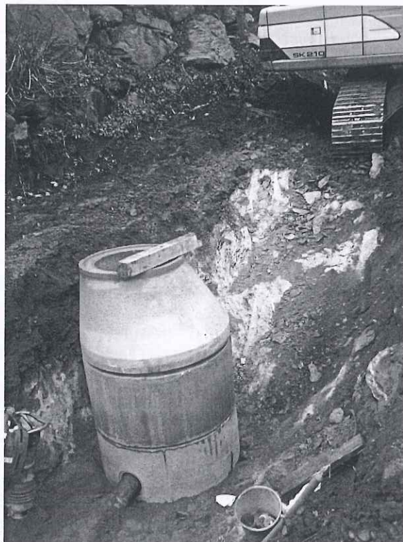
Nicht nur in finanzieller Hinsicht tauchen beim Kanalbau harte Brocken auf, wie z.B. beim Hausanschlussschacht HNr. 57
