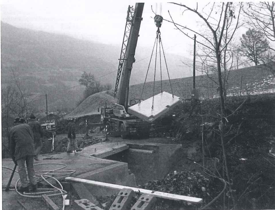
Einheben der Betonelemente bei der Rueps-Brücke
