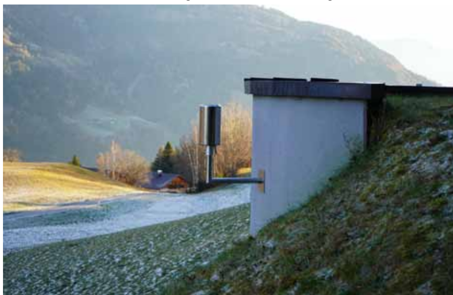
Jeder aufmerksame Spaziergänger wird bemerkt haben, dass außen am Hochbehälter ein Edelstahlrohr montiert ist. Das Städt. Wasserwerk Lienz wird hier eine Wetterstation einrichten. Diese Daten könnten dann auch über die Homepage der Gemeinde abgerufen werden.
