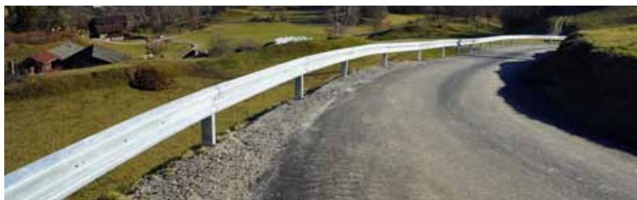
Fahrbahnabsicherung in Lärchenholz im Bereich der Hofstelle Wölfele und Alu-Leitschienen als Sicherung oberhalb vom Zenzer Nußbaum (der Namensgeber vom Flurnamen ist leider seit vielen Jahren nicht mehr zu sehen)
