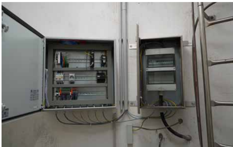
Jede Menge an Installation ist notwendig, damit die Daten vom Hochbehälter gesammelt, gespeichert, aufbereitet und weiterverwendet werden können.
