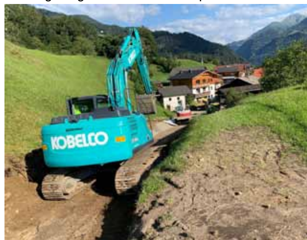
Mitte Juli wühlte sich der erste Bagger vom Zenzer über den Wölfeleweg hinauf.
