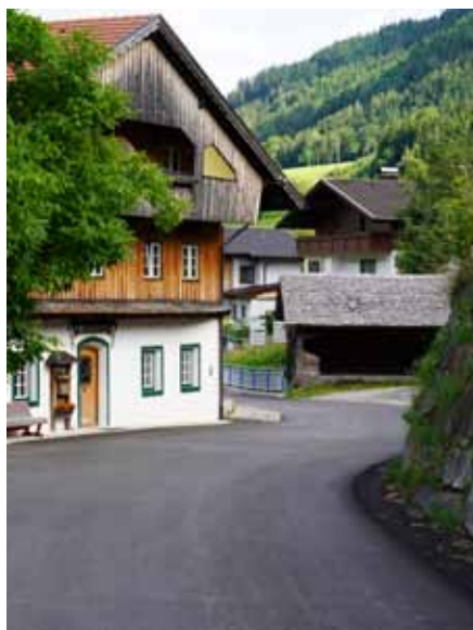
Im Auftrag der Landesstraßenverwaltung hat die Firma Swietelsky die Sanierung der Fahrbahndecke auf der Schlaitener Landesstraße äußerst professionell durchgeführt. Bei dem Ergebnis nimmt die Bevölkerung die eine oder andere Straßensperre auch gerne in Kauf.
