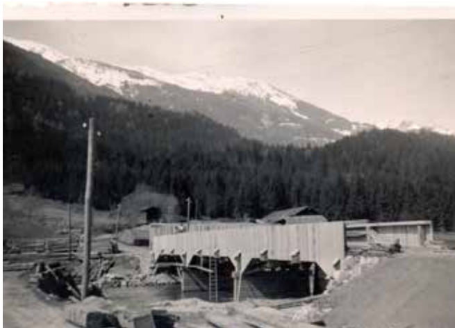
Die im Jahre 1935 errichtete Schlaitner Brücke wurde durch das Hochwasser am 2. September 1965 zerstört.
