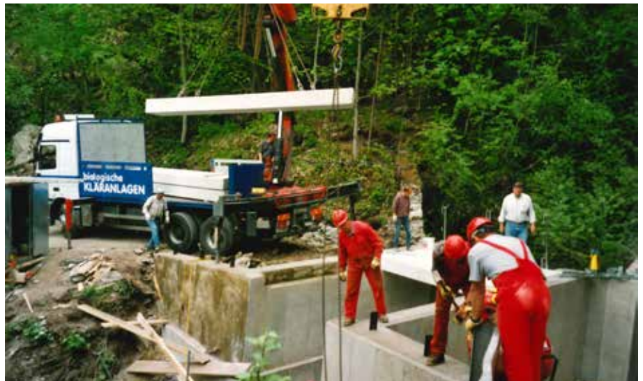
Die Daberlebrücke wurde im Jahre 2001 erneuert - 5 Stk Stahlbetonfertigteile mit den Abmessungen ca. 600x110x30 cm.
