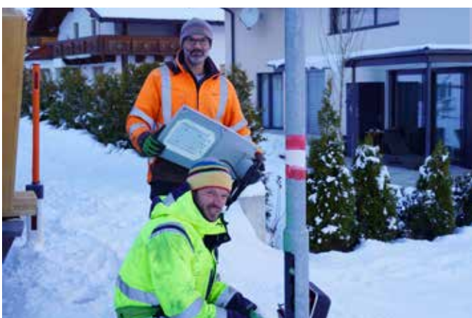
Am Sonntag, 1. August hat ein gewaltiger Blitzschlag in zahlreichen Häusern einen großen Schaden angerichtet. Auch die Gemeinde blieb nicht verschont. Fast ein Dutzend LED-Straßenbeleuchtungskörper waren kaputt. Nach 4-monatiger Lieferzeit konnten die Gemeindearbeiten endlich wieder Licht ins Dunkel von so manchen Straßen und Plätzen bringen.
