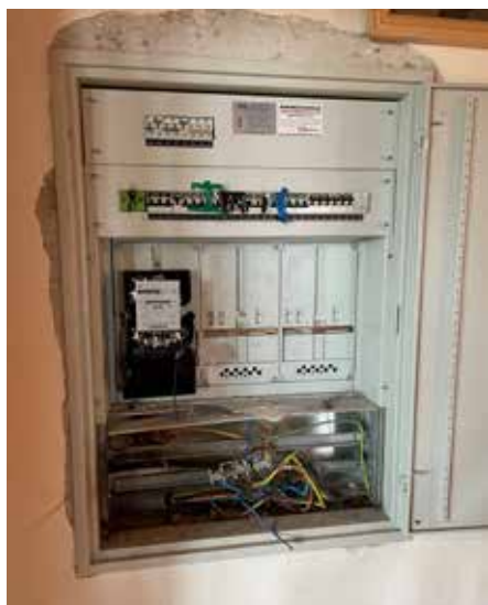
Die Schäden durch den Blitzschlag am 01.08.2021 waren überall enorm. Am größten waren die Schäden auf der Zenz-Wiese.
