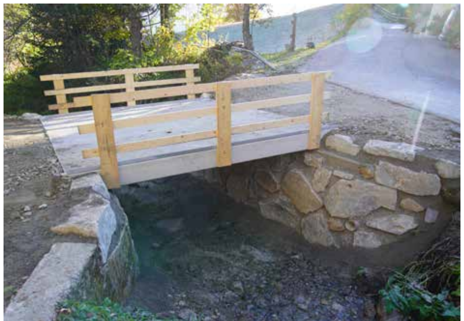
Josef Strieder versetzt gemeinsam mit einem Mitarbeiter der Wildbach- und Lawinverbauung die 3 Betondielen der Oberfotzbrücke. Die Widerlager wurden gänzlich erneuert. Das provisorische Geländer wird im kommenden Frühjahr ersetzt.
