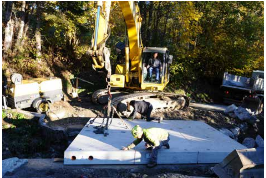
Josef Strieder versetzt gemeinsam mit einem Mitarbeiter der Wildbach- und Lawinverbauung die 3 Betondielen der Oberfotzbrücke. Die Widerlager wurden gänzlich erneuert. Das provisorische Geländer wird im kommenden Frühjahr ersetzt.
