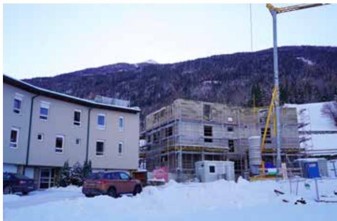
Kellergeschoss und 3 Obergeschosse sind bei der OSG-Wohnanlage Gäntschfeld II fertiggestellt. Im Frühjahr wird noch das 4. OG aufgesetzt. Dieses Geschoß ist zurückgesetzt und hat nur mehr die Hälfte vom unteren Ausmaß.
