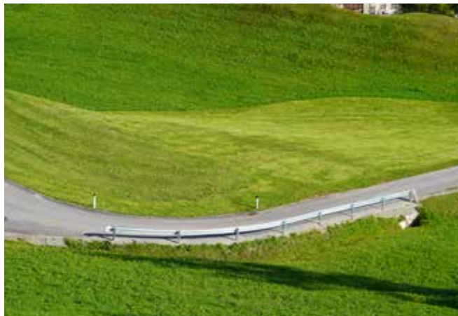
Am Wölfeleweg wurden im Frühjahr die letzten Adaptierungsarbeiten vorgenommen und noch Leitschienen montiert. Die Deponiefläche war im September bereits bestes Grünland. Die Grundablösen wurden bereits abgerechnet und die Weganlage in das öffentliche Gut der Gemeinde übertragen.
