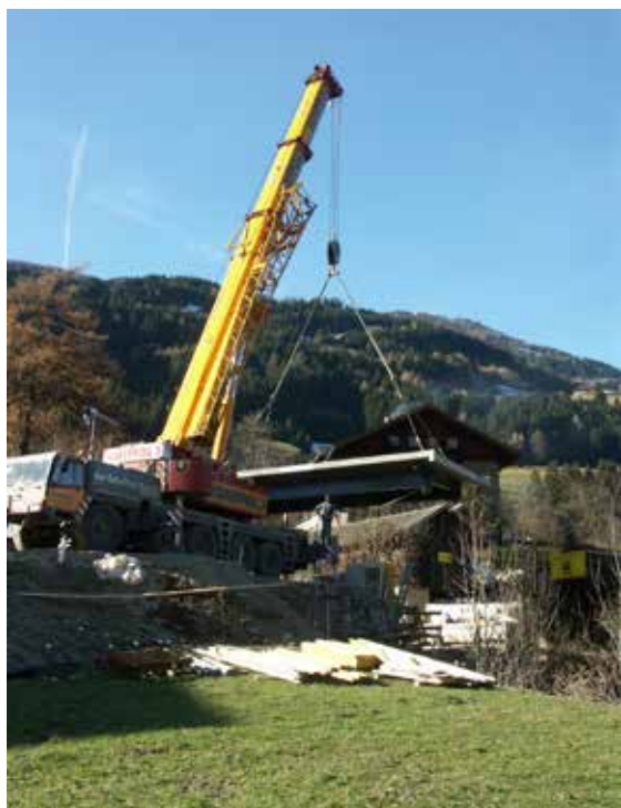
Die gesamte Fahrbahn der Wegscheiderbrücke wurde in einem Stück angeliefert (12 m lang, 5,50 m breit, 45 Tonnen)
