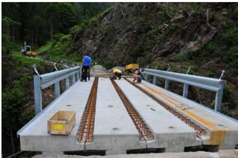
Die Gasserbrücke ist mit einer Gesamtlänge von 10,50 Meter die längste Brücke. Jedes der 4 Betonteile wiegt an die 10 Tonnen. Die Tragkraft beträgt 440 kN bzw. 44 Tonnen. Die frühere Gasserbrücke hatte eine Tragkraft von 16 to (5 Stk INP-Stahlträger 450 mm + 16 cm Holzdielen)
