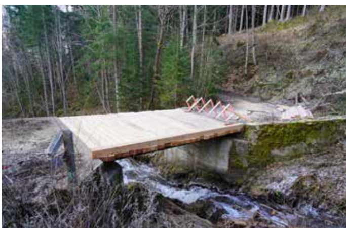
Die Göriacher Sägbrücke wurde zuletzt im Jahre 2005 erneuert. Die Brücke hat eine Lichte Weite von 5,20 m und ist auf eine Tragfähigkeit von 250 kN bzw. 25 t ausgelegt.
