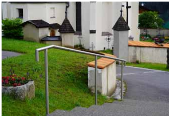
Die Firma Florian Gomig, Metalltechnik, wurde vom GR beauftragt, Edelstahlgeländer für zwei Friedhofszugänge zu fertigen und zu montieren.
