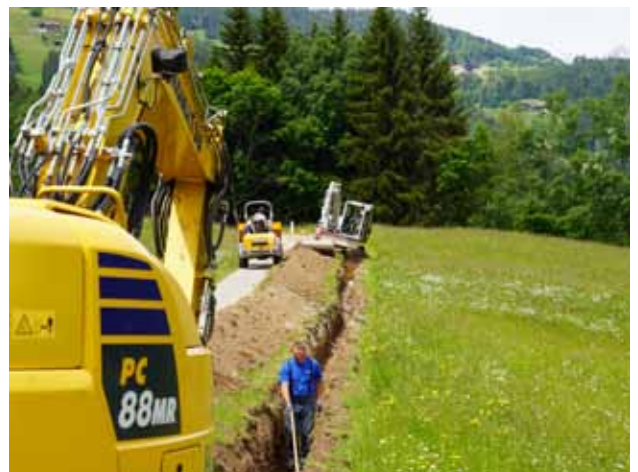
Zugleich mit der LWL-Leerverrohrung wurde auch endlich die Stromversorgung zum Hochbehälter mitverlegt.
