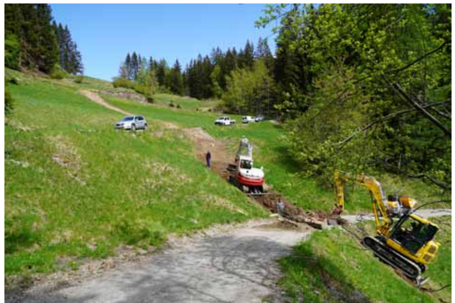
LWL-Ausbau in Göriach: Grabungsarbeiten zwischen Untertschellnig und Leite
