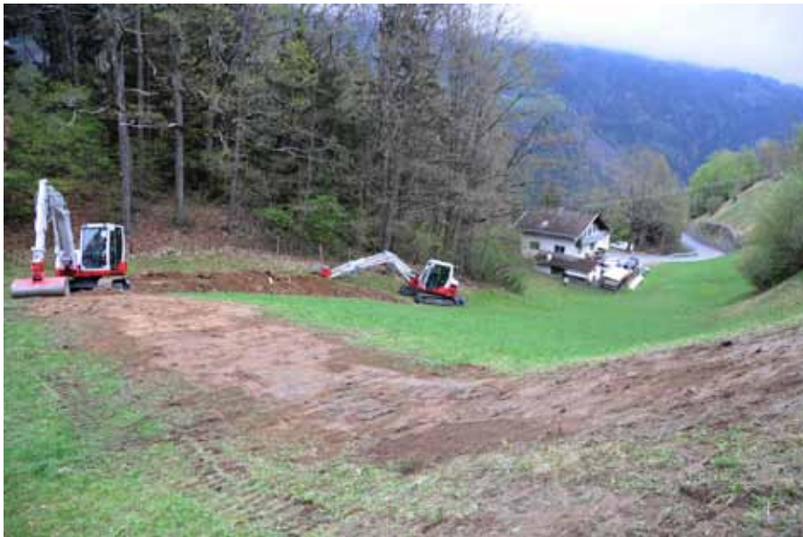
LWL-Ausbau in Richtung Ingruber vlg. Eichbichler
