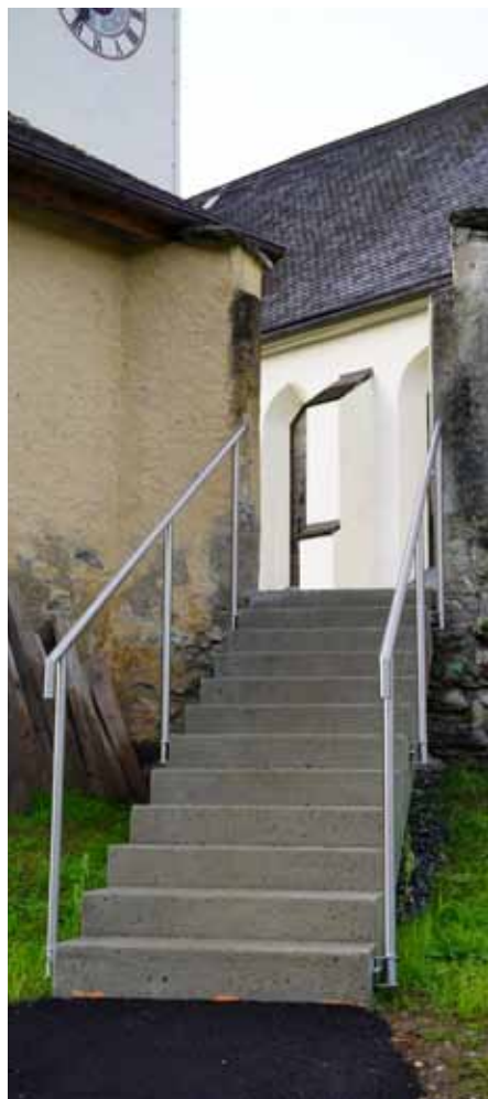
Die nordseitige Friedhofstiege wurde mit einem beidseitigen Edelstahlhandlauf versehen.
