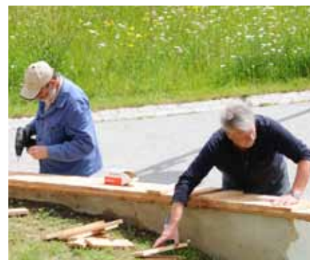
Die Gemeinde stellte die Lärchenbretter und die Pfarre organisierte mit rüstigen Pensionisten die Eindeckung der Mauer. links: Christian Brugger und Josef Klauzner oben: Leopold Gantschnig und Peter Paul Lumaßegger
