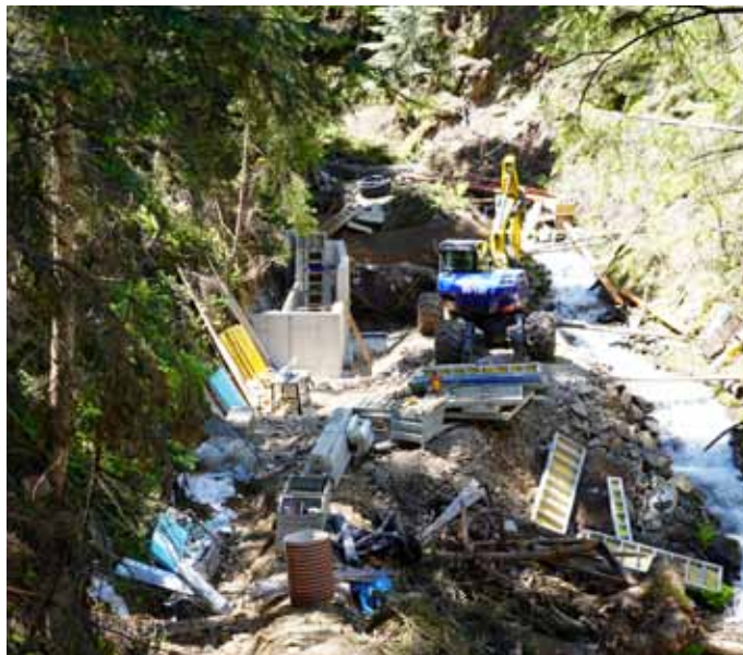
Der plötzliche Wintereinbruch im November 2019 verhinderte die Fertigstellung der Wasserfassung am Schlaitenbach für das Kleinkraftwerk der Familie Gantschnig vlg. Fotz. Die Arbeiten konnten heuer im Juni fertiggestellt werden. Die Druckrohrleitung wurde bereits im Vorjahr erneuert.
