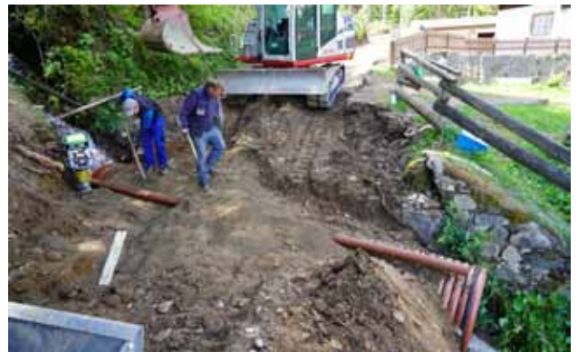
Im Zuge der LWL-Leerrohrverlegung wurde auch der letzte Abschnitt zum Wohnhaus Gonzach 52 - Aloisia Lumaßegger saniert und anstatt der Holzbrücke ein Rohrdurchlass DN 800 eingebaut. Die Asphaltierung erfolgt im Herbst 2020.
