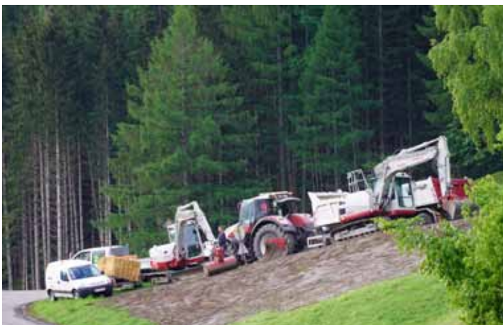
Um 7 Uhr früh bei der Baustellenbesprechung kann es schon einmal etwas eng sein. Gerade noch Platz für einen Babyelefanten.
