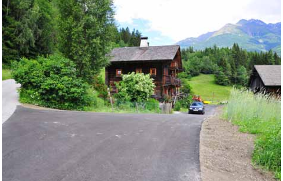
Die Hofstelle Obertschellnig mit dem neuen Erschließungsweg
