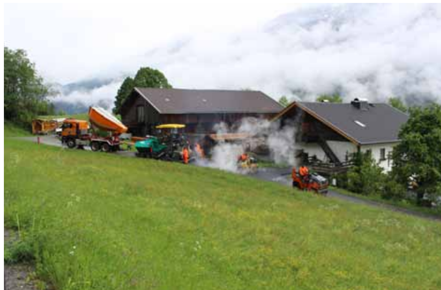
Die Asphalttermaschinen beim Kraßhof im Einsatz
