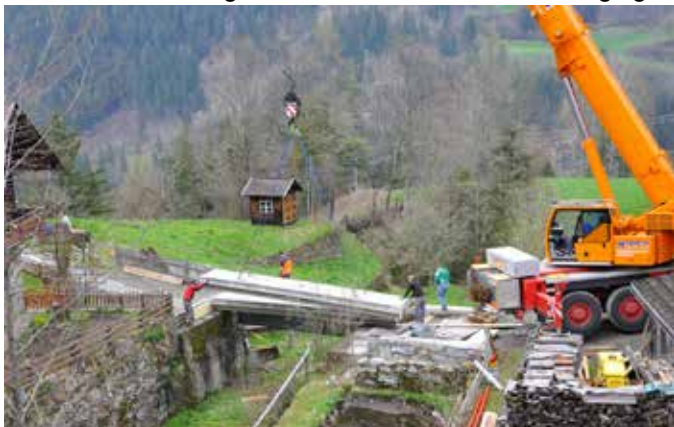
Die Firma Mangweth beim Versetzen der Betonfertigteile. Jedes einzelne Element hat ein Gewicht von 9,8 to.
