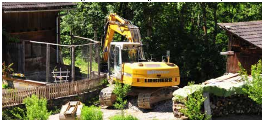
Nicht nur für die Hausbewohner beim Niedertscheider eine anstrengende Zeit. Auch die Hennen beim Brugger mussten für einige Tage in Deckung gehen, als sich der Bagger mit dem Schremmhammer den Weg zwischen „Hennstall“ und Holzhütte bahnte. Nun können die glücklichen Hühner wieder ganz entspannt Eier legen.
