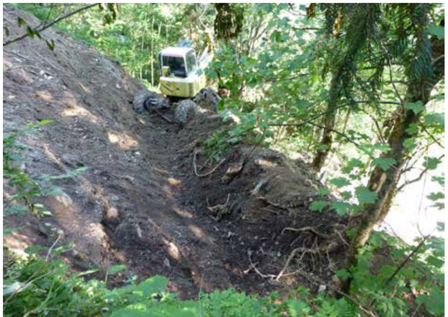
Der angelegte Damm sollte die Göriacher Straße und damit auch die Verkehrsteilnehmer bei kleinen und mittleren Felsabbrüchen ausreichend schützen.
