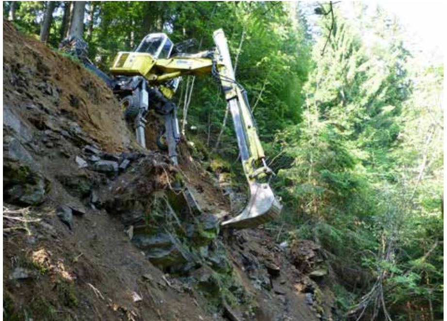
Auch der Schreitbagger der Firma Wibmer musste bei den Felsräumarbeiten separat gesichert werden. Fotos: Urban Pedarnig
