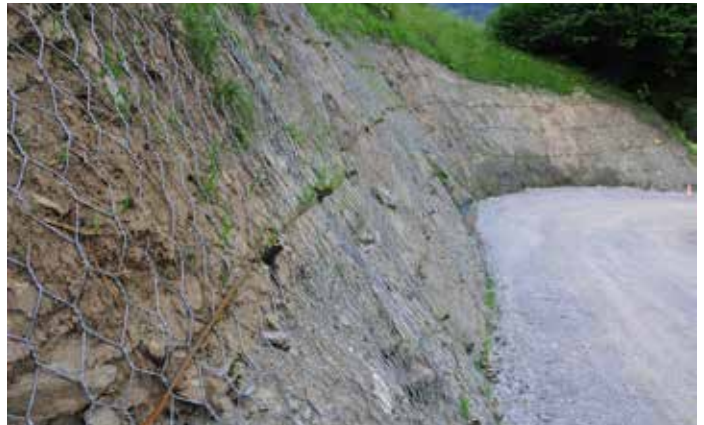
Über 300 Erdnägel mit Längen von 40 – 120 cm sichern das Felsgitter und damit die bergseitige Böschung im Bereich der letzten Kehre zum Daberer.
