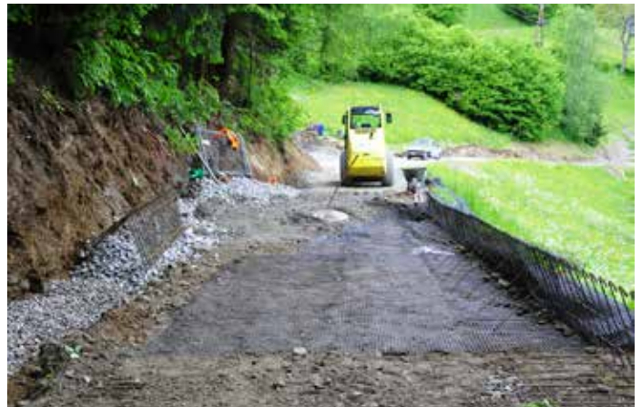
Durch das Geogitter und die Winkelmatten ergibt sich eine statische Einheit von Wegbaukörper und Böschung.
