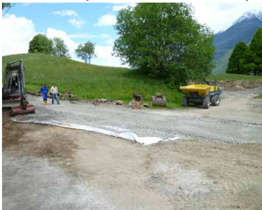
Das Geotextil wurde in diesem Bereich eingebaut, um einerseits den Wegbaukörper vom stark vernässten Bereich herauszuheben und andererseits auch Gefälleunterschiede auszugleichen. Im Bereich der Hofstelle vlg. Innerkraß wurde die alte Auffahrung abgetragen und die Zufahrt großzügig aufgeweitet.
