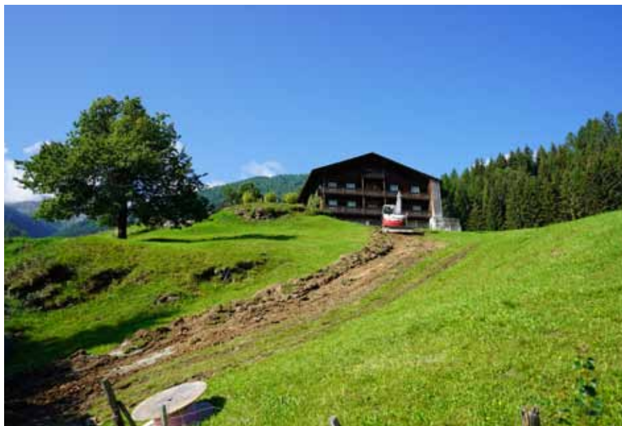
Ende August 2019 wurde die Leerverrohrung bis zur Hofstelle vlg. Gant verlegt.
