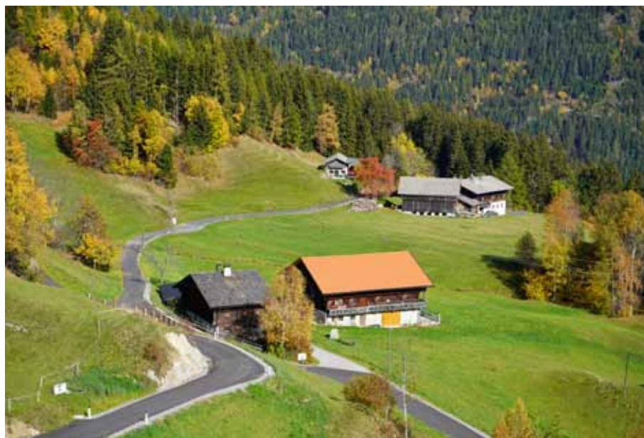
Mit der Generalsanierung des Gasserweges wurde auch die Zufahrt zum Untertschellnig asphaltiert und in das Öffentliche Gut der Gemeinde übernommen.
