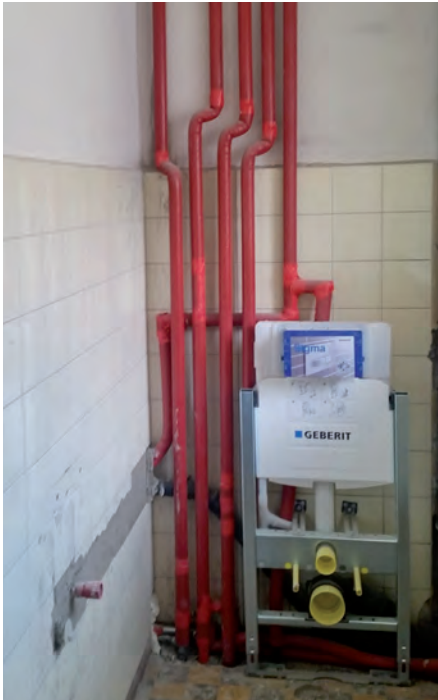
Die WC-Anlagen und erforderlichen Leitungen wurden erneuert.
