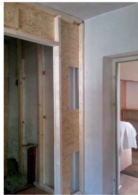
Hinter einer neuen Trennwand im ehemaligen Schlafzimmer entstanden die privaten Sanitärräume.
