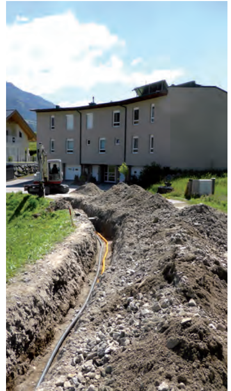
Im Zuge der restlichen Asphaltierung in der Gantschfeld-Siedlung wurde auch jeder Baugrund mit einer LWL-Leerverrohrung versorgt und die Straßenbeleuchtung um einen Lichtpunkt erweitert.
