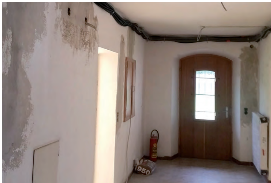
Das Pfarrwidum wurde im Innenbereich umfassend saniert und umgebaut. Von außen ist derzeit noch nichts Neues zu erkennen, zumal auch die neuen Fenster dem Altbestand angepasst wurden. Die Fassade soll 2017 erneuert werden.
